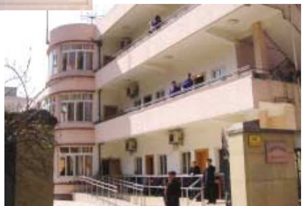
幼稚園を改修した3階建ての敬老院
