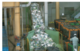
ごみを搬入したプラットホーム
