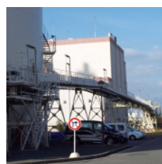
RDF搬送用ベルトコンベア
